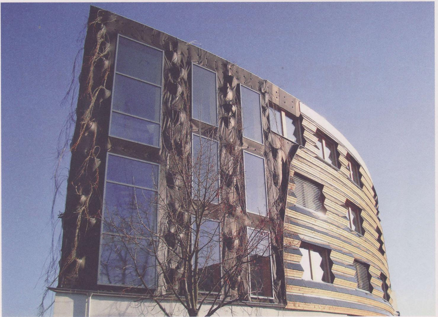
Aus der Südfassade wachsen Farne, Flieder und andere Pflanzen (links). Rechts an der Fassade sind die dreieckigen Profile mit den Photovoltaik-Paneelelen zu erkennen (Ruedi Tobler).
